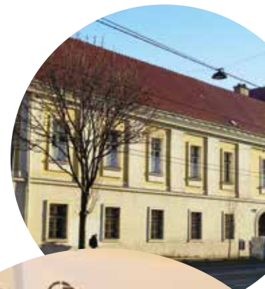
Abb. 1: Transformer-Gebäude am Rennweg 89a im III. Bezirk.
