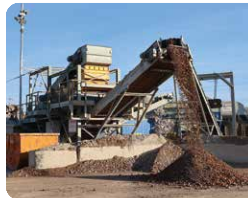
Mehr als 300.000 t Recyclingbaustoffe entstehen jährlich im RCH.
